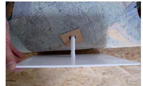
(II.) Fahnenfuß positionieren
